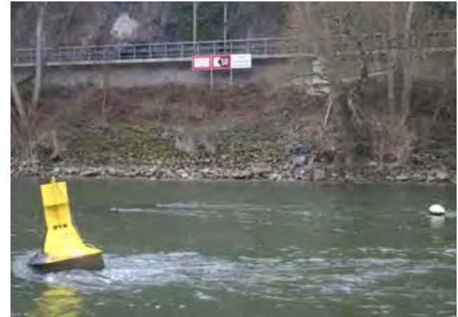
Die gelbe Tonne weist in Kombination mit dem Schild an Land auf eine Wasserkraftanlage kurz unter der Oberfläche. Die Tonne markiert damit eine Gefahrenstelle im Wasser.
