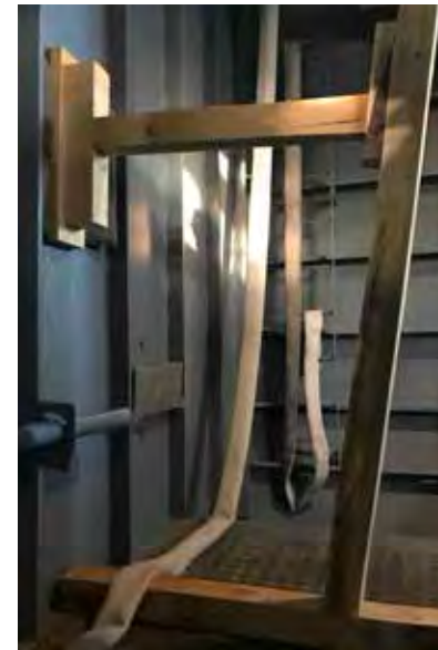
Herstellung eines Druckstempels zur Abdichtung eines Bodenschotts
